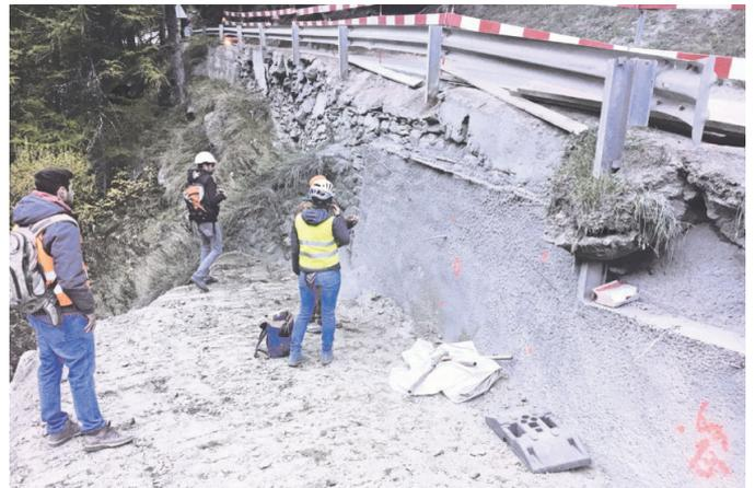
Sicherung. Bis Ende Jahr gehen die Sicherungsarbeiten an den Stützmauern weiter. Damit steht dem Verkehr dann wieder die volle Strassenbreite zur Verfügung.
