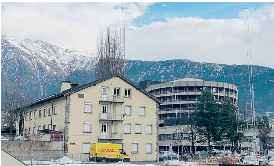
Im Frühjahr beginnen die Arbeiten für den Spitalneubau, als Erstes wird die Kaserne abgerissen.
