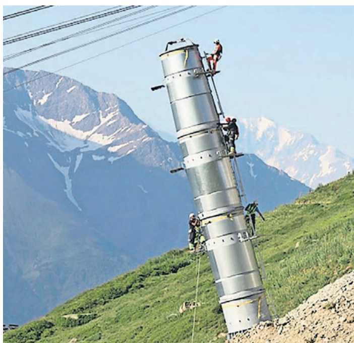
Balanceakt. Monteure errichten unterhalb der Bergstation einen der insgesamt 13 Stützmasten. FOTO ZVG
