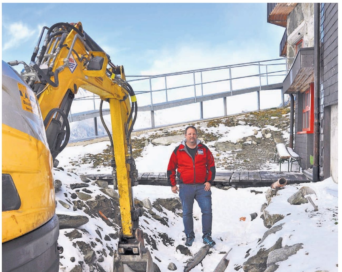
Aushub. Mathias Lorenz, Betriebsleiter Aletsch Bahnen AG, in der Baugrube wegen der Absenkungen.
