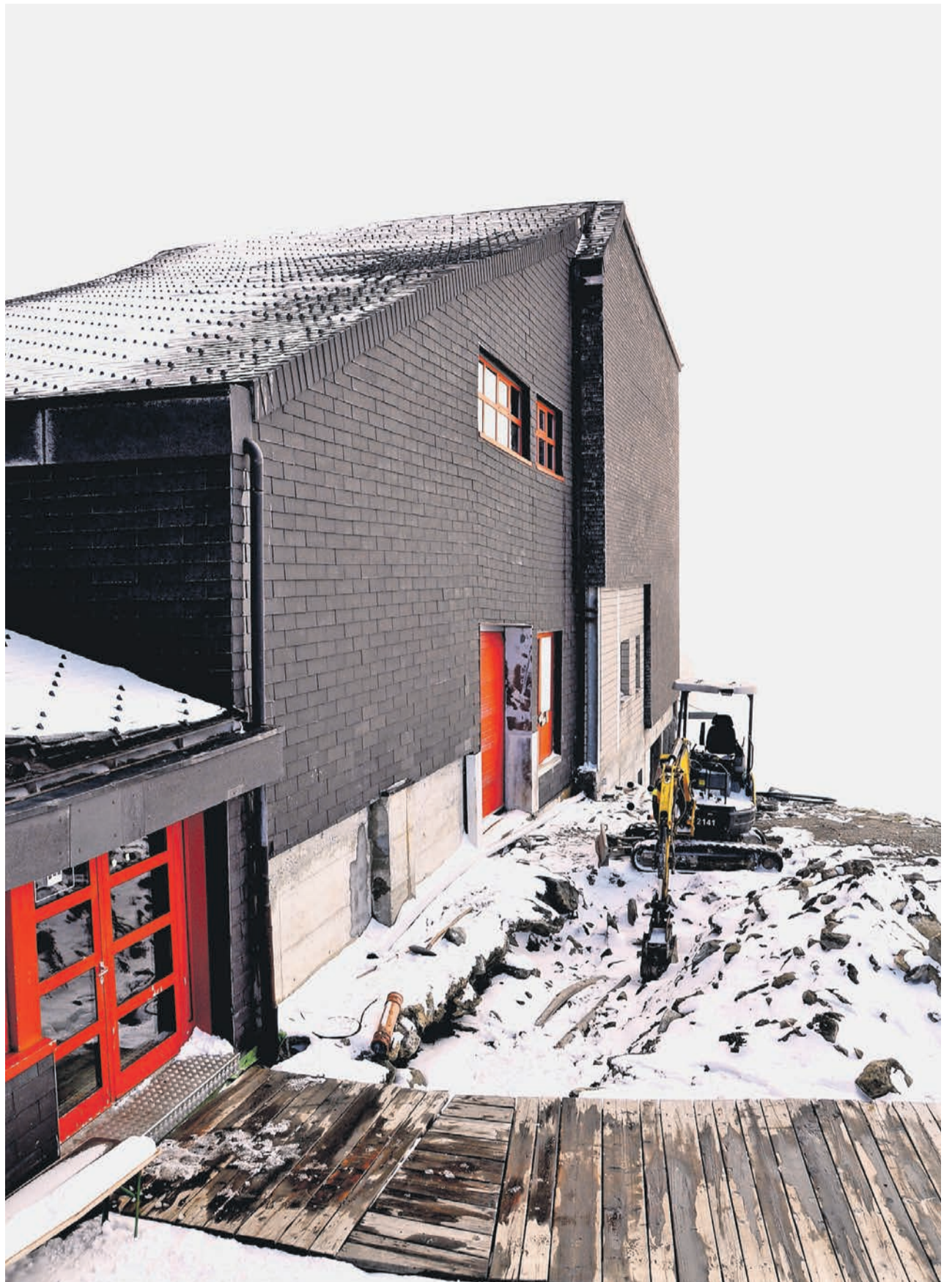
Bergstation Eggishorn. Der kleine Bagger hat die Leitungen freigelegt. Die Ingenieure bestimmen das weitere Vorgehen.
