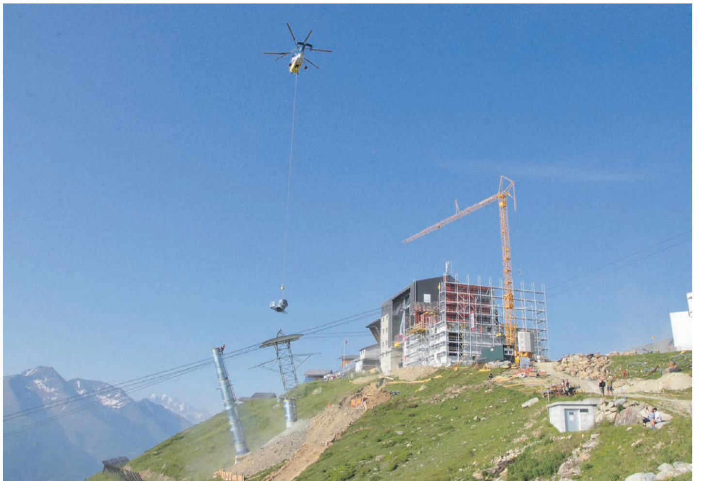
Eindrucksvoll. Der Schwerlasthelikopter «Kamov» fliegt Elemente der Stützmasten 12 und 13 zur Bergstation.
