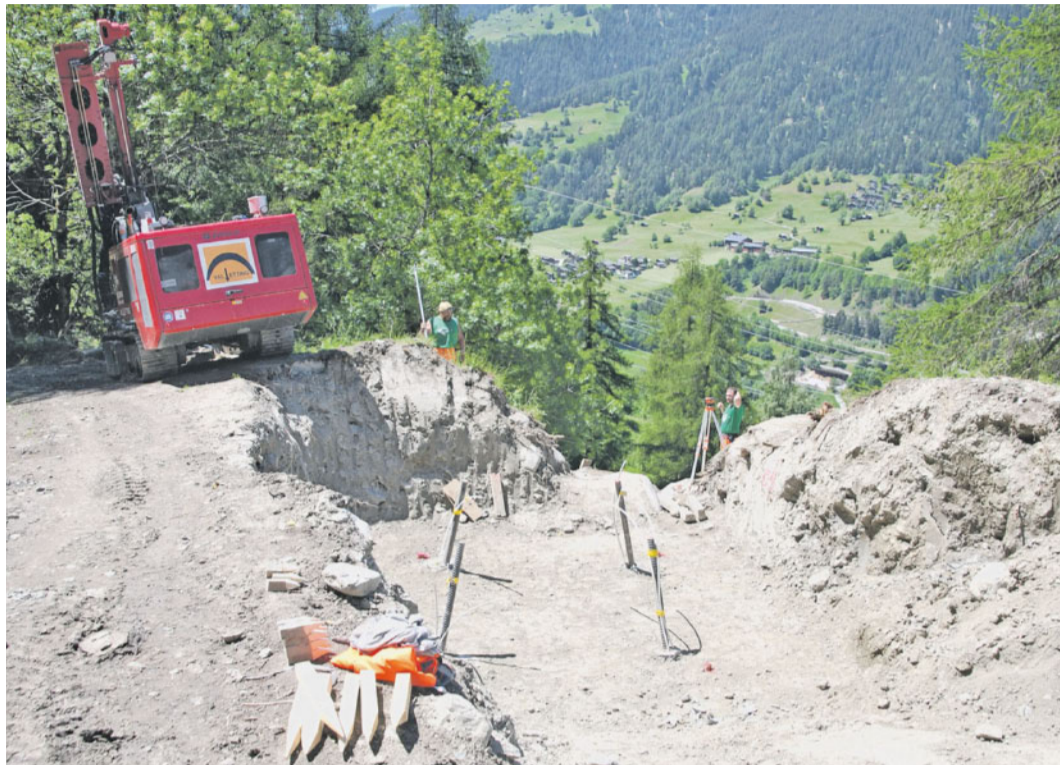
Aushubarbeiten. In dieser Vertiefung wird ein Fuss eines Mastens verankert.
